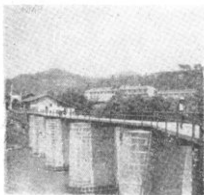
新改建的洋溪板板桥
