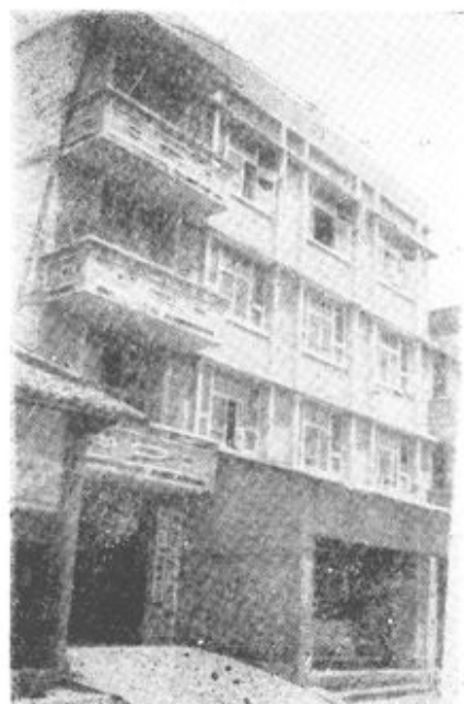
射洪县公路养护段
