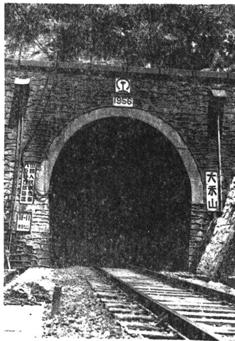
廣厦铁路线上的大禾山坠道
