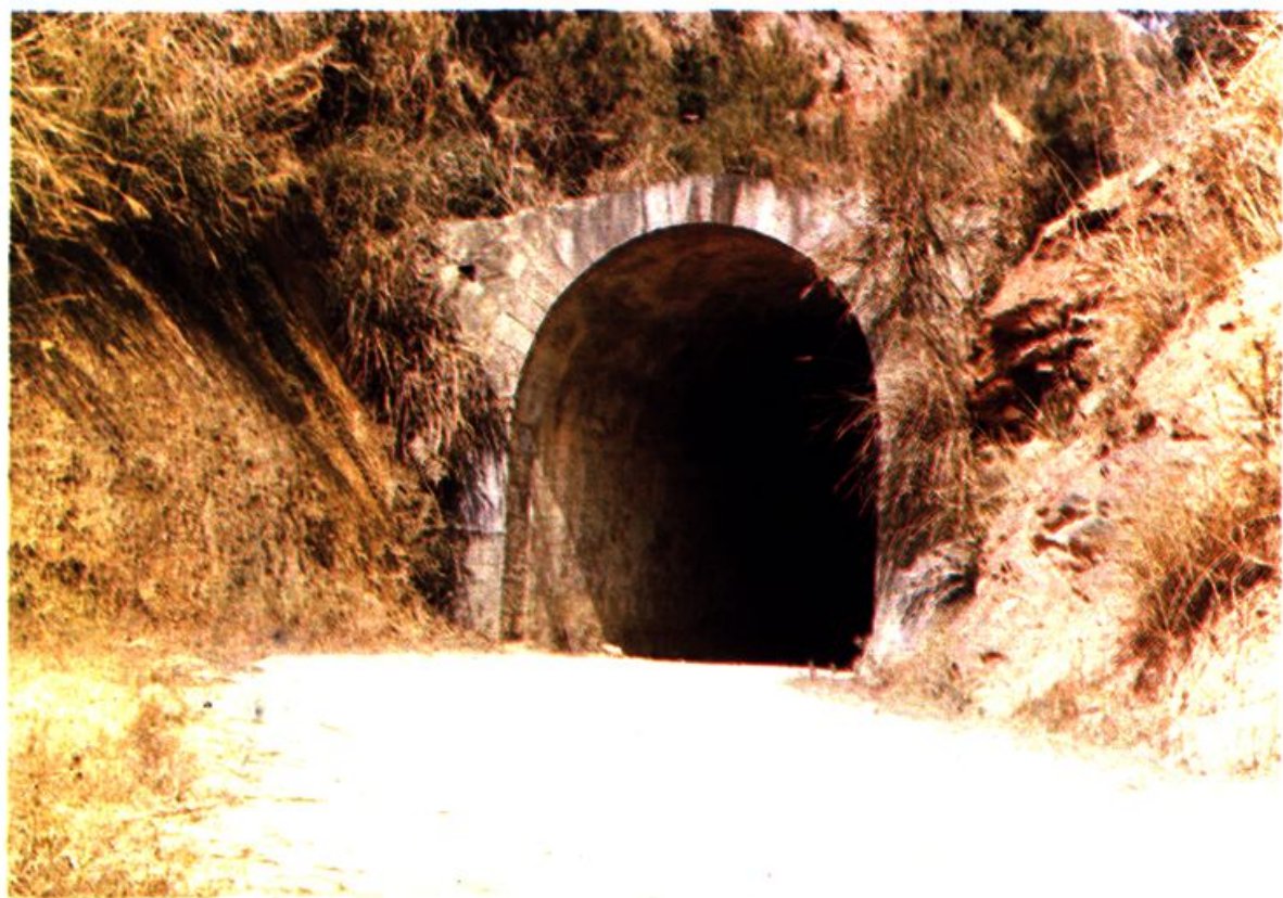
大青村半山公路隧道
