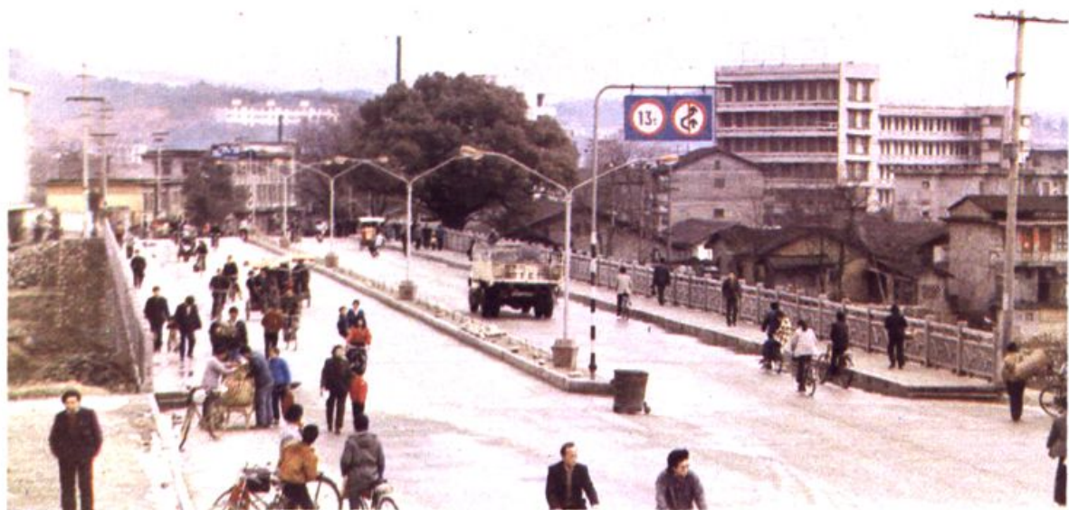
光泽跃进大桥
