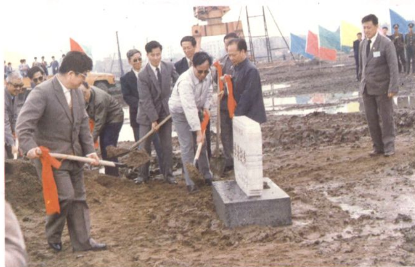
1988年6月 高严、米凤君等省、 市领导为开工奠基
