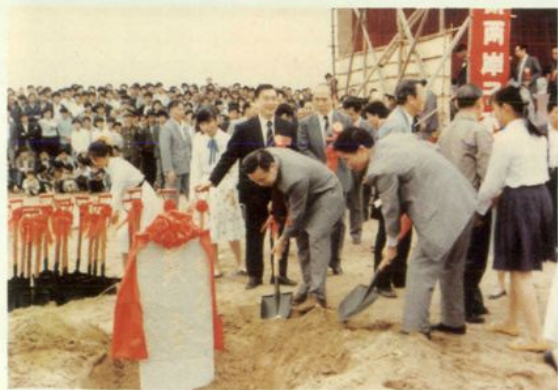
1989年4月12日，高明大桥奠基。
