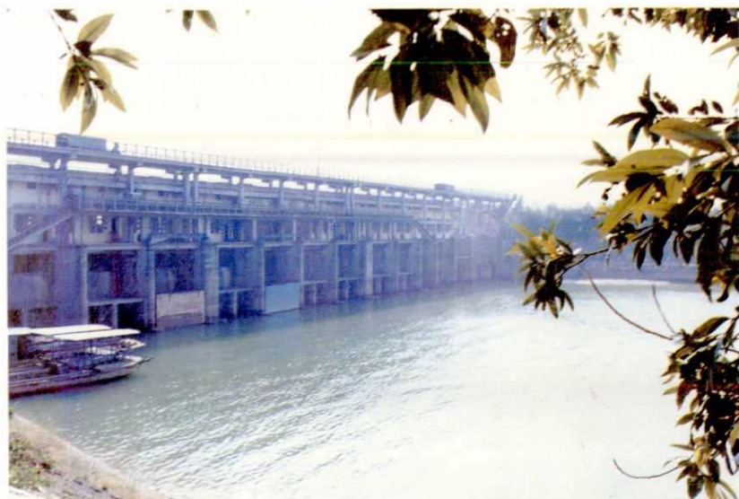
甘竹洪潮发电站
