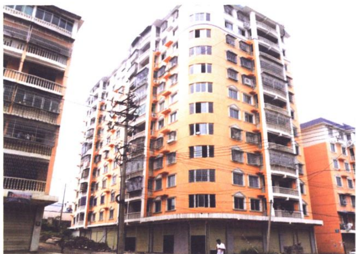
城南大道西段的11层电梯楼
