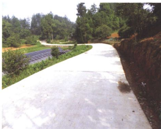
已实现硬化 朱家场镇茅坡村通组路、连户路
