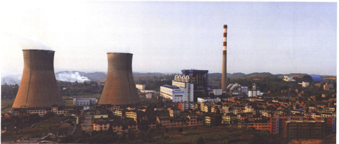
贵州华电大龙2×30万千瓦火电厂
