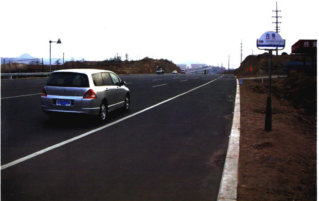
青岛滨海大道沟崖段（2006年摄）
