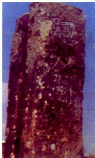
◀ 鄞县它山堰迺沙闸遗址(宋淳祐二年(1242)建)现存石柱四根,西首第二根柱 镌有“则水尺”三字,傍刻尺寸,第三根柱镌有“迺沙闸”三字。
