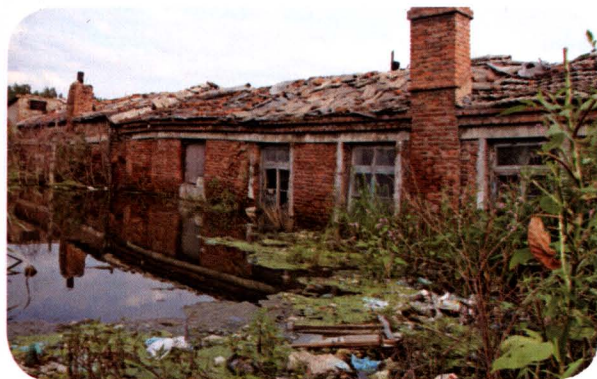
20世纪80年代的采煤沉陷区民房
