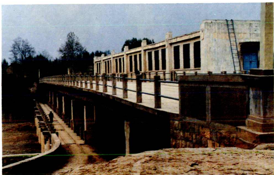
▷ 为排涝和协调金堤河水事纠纷，1964年5月建成的张庄抽排入黄闸
