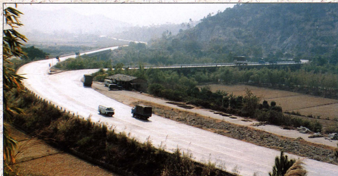
● 改造后的漳浦盘陀岭公路
