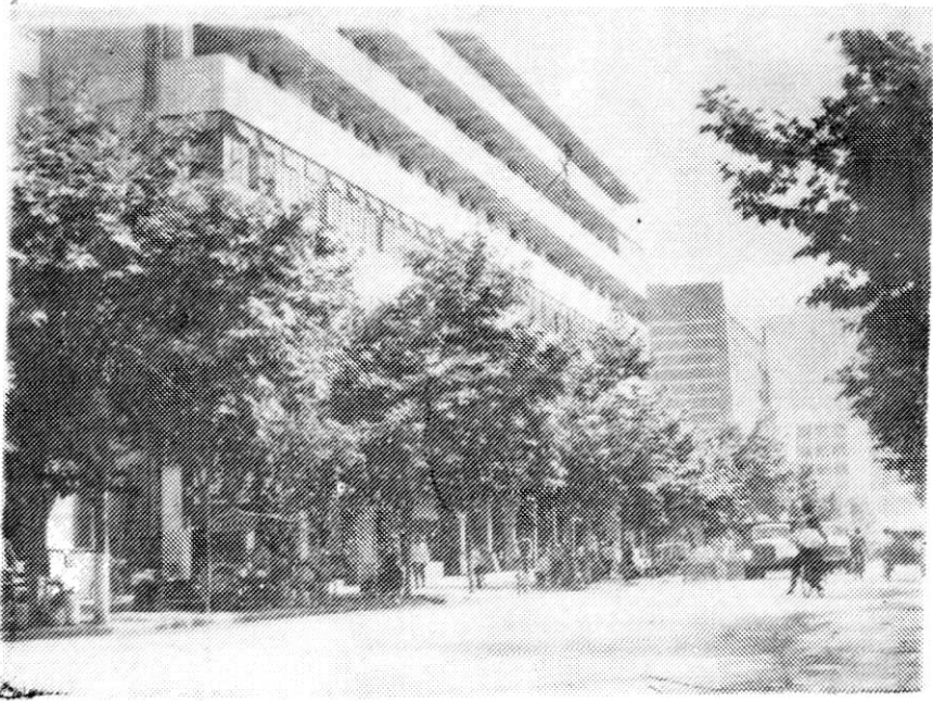
照片 5 五交化公司五交化大楼
