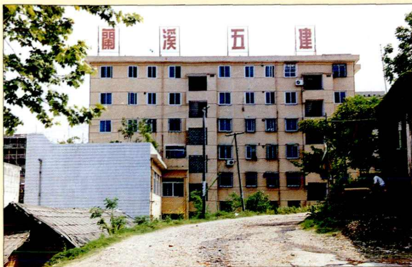
兰溪市第五建筑公司
