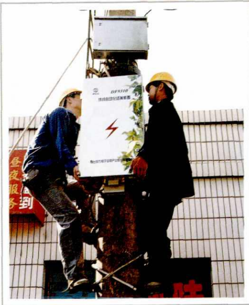
调配一体化安装
