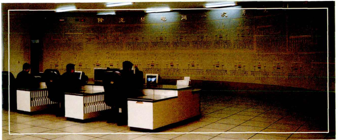
隆尧县电力调度中心
