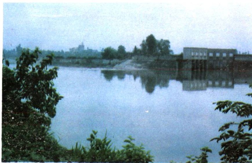
马棚堰枢纽工程
