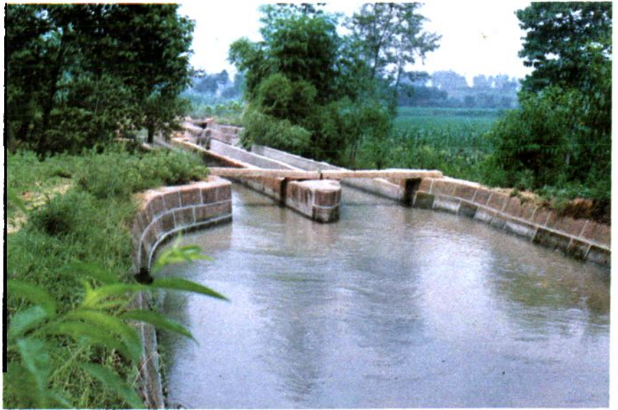
东支七双渡槽
