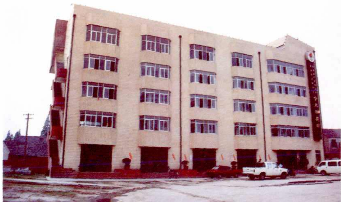
合肥石油站办公楼
