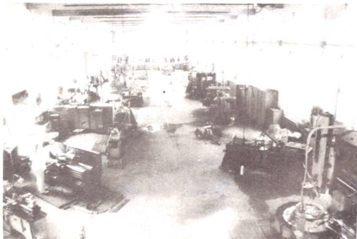
机修车间内景
