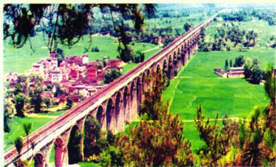
罗定市长岗坡渡槽
