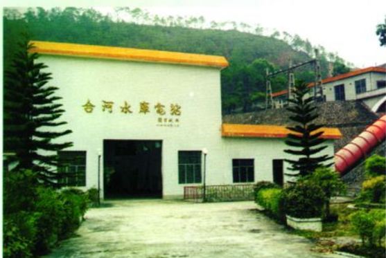
新兴县合水水库电站
