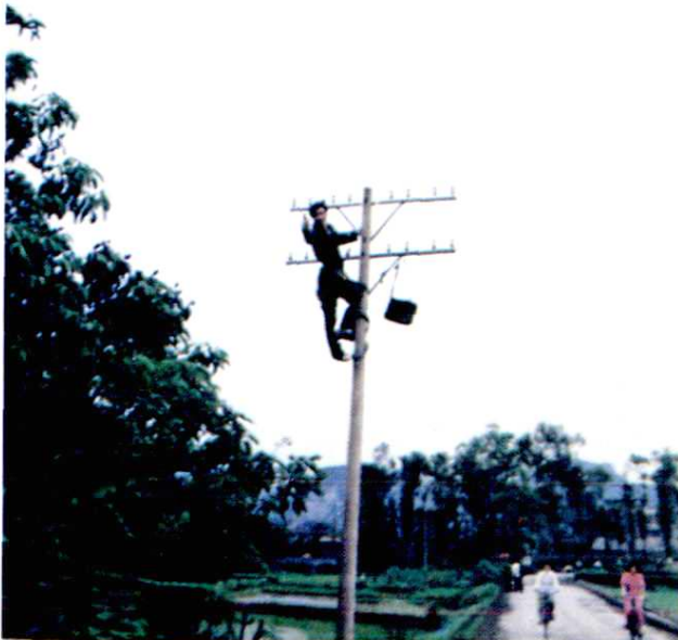
线务员在维修线路
