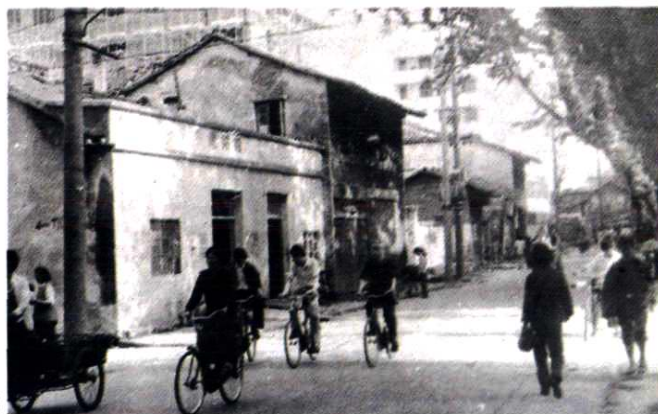
市区下街改造前旧貌
