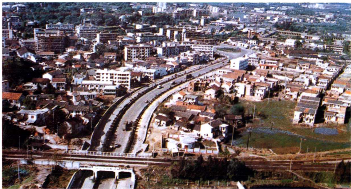
衢州市区东立交桥
