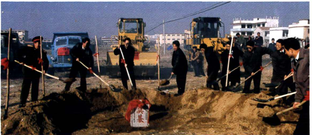
市委、市政府、市人大、市政协、衢州军分区领导参加市区中立立交桥工程奠基典礼
