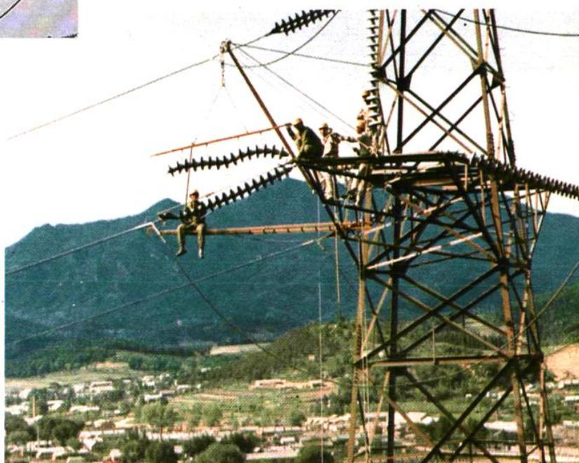
▲ 八十年代带电更换220千伏耐张整串瓷瓶
