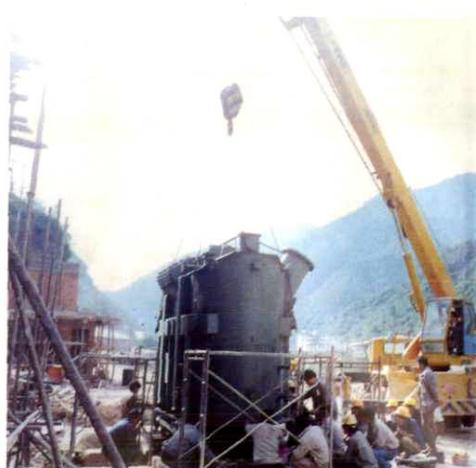
正在吊装4万千瓦安主变压器
