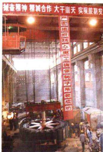
山仔1.5万千瓦发电机转子吊装
