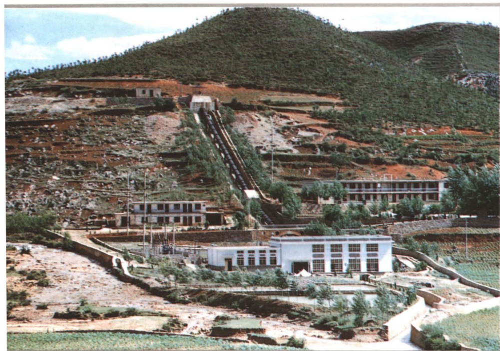
威宁县羊街 一级水力发电站
