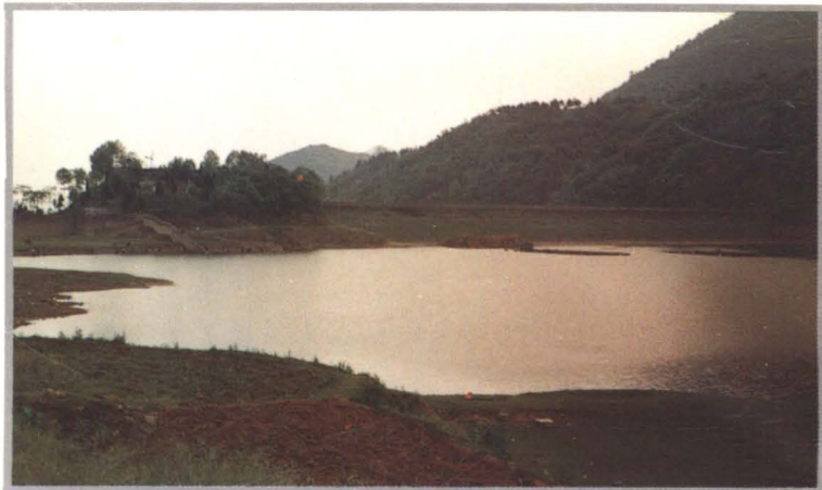
金沙县西洛河水库土坝
