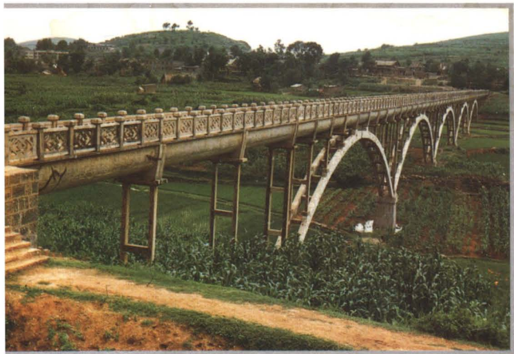
黔西县附廓水库 “U”型薄壳渡槽。
