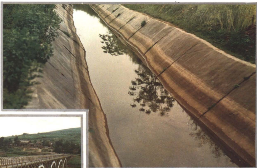
金沙县西洛河水库 总干渠混凝土防渗衬 砌
