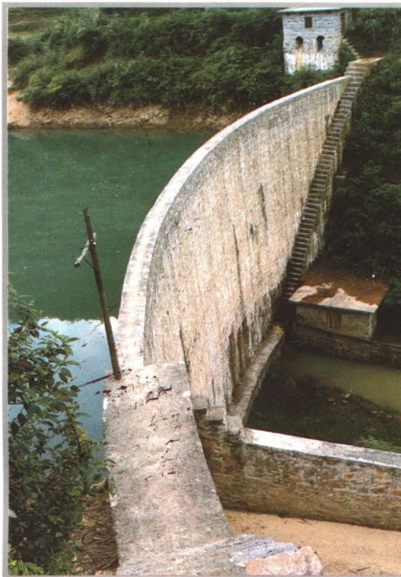
金沙县小沟水库部分 半周边缝浆砌石薄拱坝
