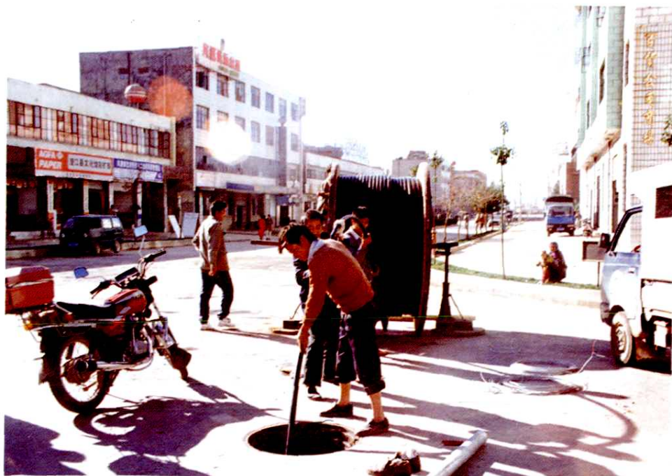
县城地下管道通信电缆施工
