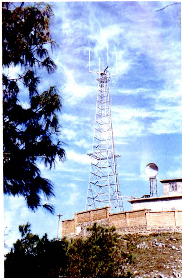
设在海拔 2793 米处梁王山移动通信传输基站
