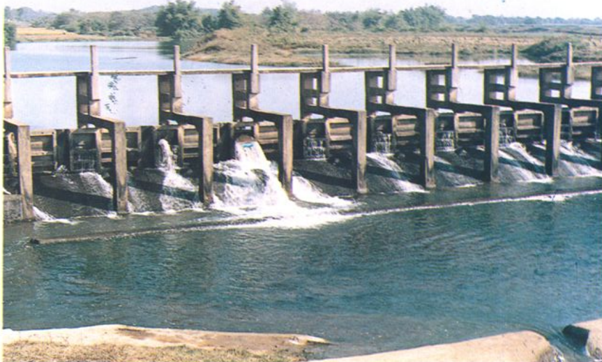
梁化河引水工程
