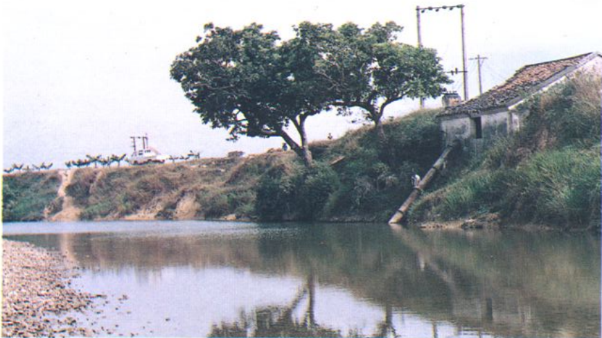
陈江东楼电灌站
