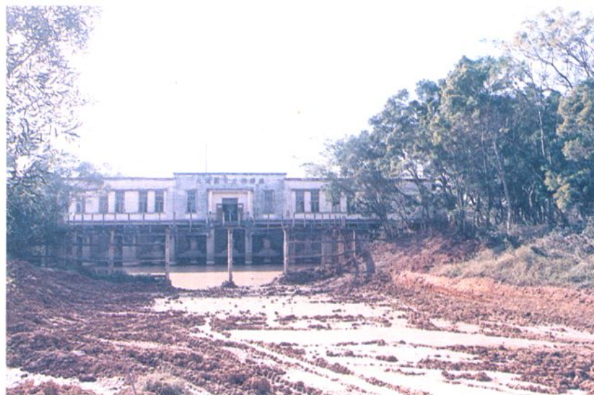
马安围大湖溪排涝站
