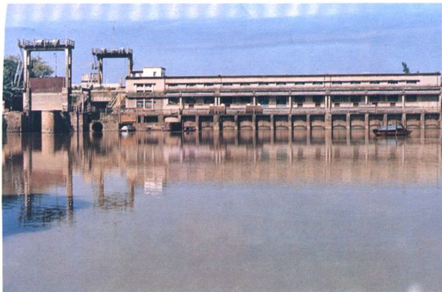
潼湖围东岸排涝站
