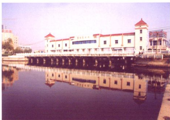
1998年改建后的丰城闸站(2008年10月摄)
