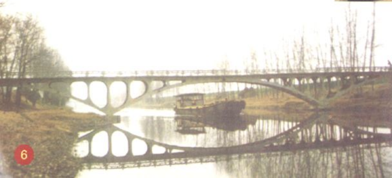
1992年白衣河张方庄桥首次采用双悬臂三铰桁架拱转体施工技术(1992年摄)
