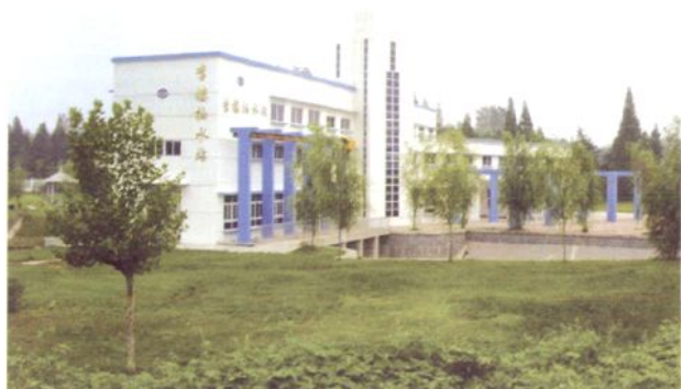
2005年李楼水利枢纽改建后的新抽水站(2006年8月摄)
