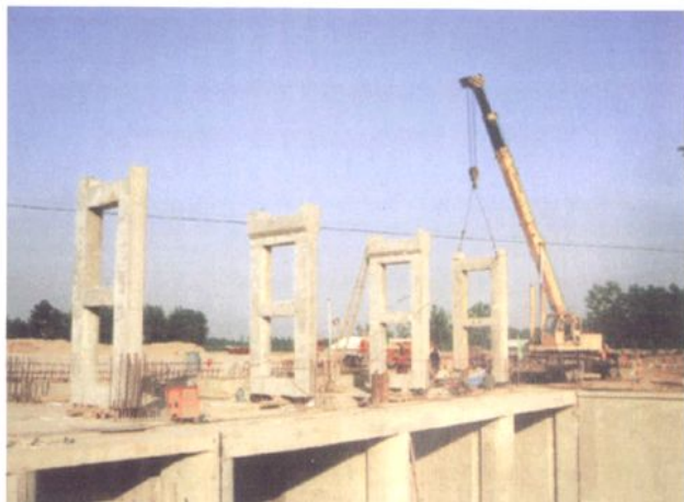
2006年韩庄闸站机械吊装施工现场
