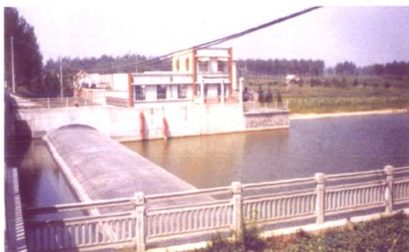
1991年兴建的大沙河县内第二级控制夹河闸——56米长橡胶坝(1999年摄)
