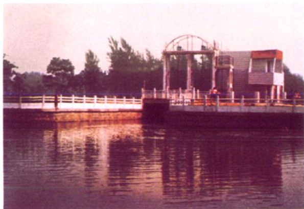
西线调水末站——黄庄闸站 (1999 年摄)
