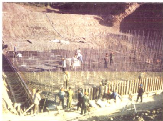
2003年李楼水利枢纽改建工程施工现场 (2003年摄)
