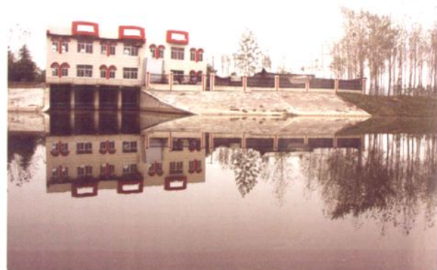
2001年建成的苗河抽水站(2008年10月摄)
