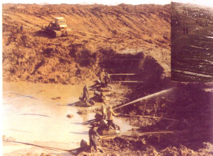
水力冲挖机组开挖大沙河(1990年摄)
