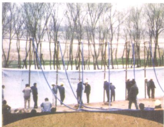
1992年,丰县水利局技术人员利用塑膜垂直防渗施工技术试验成功
