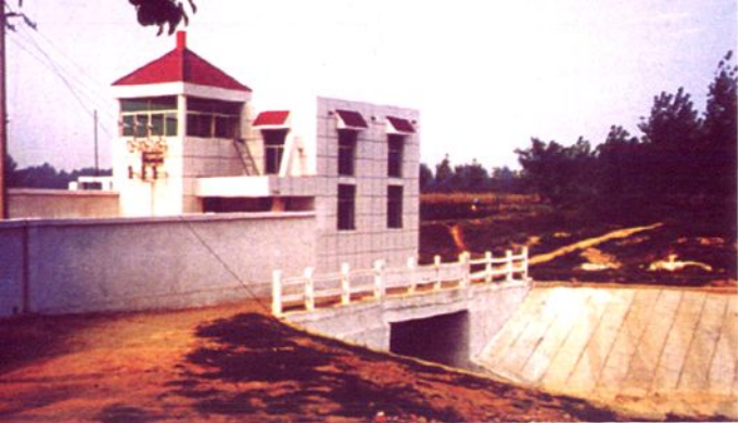
顺河镇尹庄抽水站 (1999 年摄)
