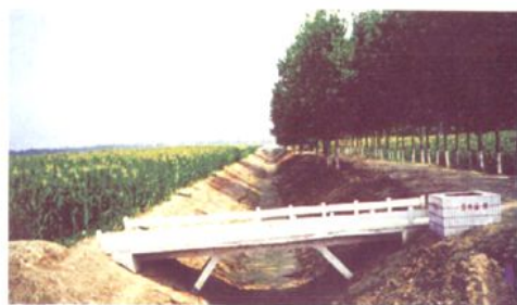
马楼乡农田装配式钢架桥(1999年摄)
