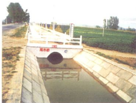
顺河镇尹庄灌区防渗渠道(1999年摄)
