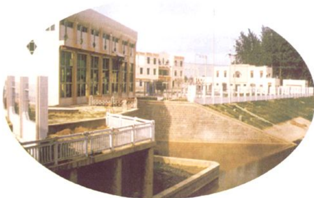
1996年增容后的南线调水第二站——梁寨抽水站(1999年摄)
