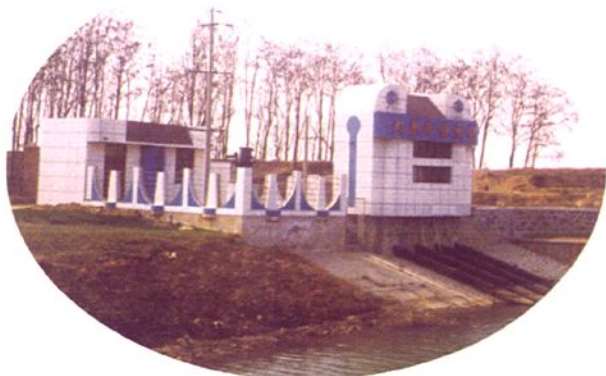
大沙河镇抽水站 (1999 年摄)
