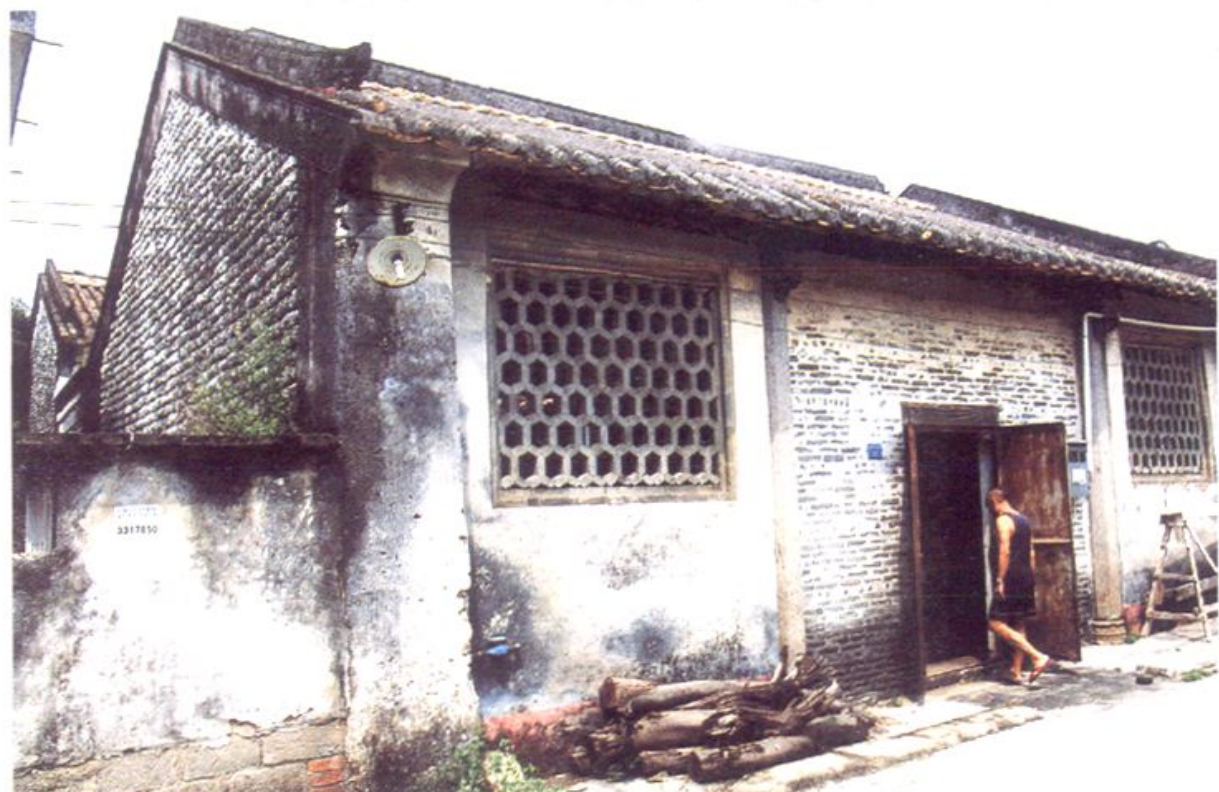
用蚝壳砌墙的上栅明代古建筑卢公祠，曾在大革命时期作过上栅农民协会会址。
