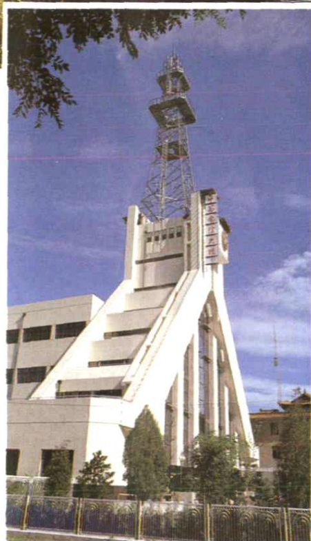
平谷县电信大楼
