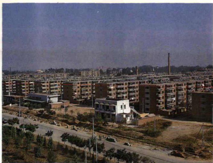
平谷镇建设街居民南小区
