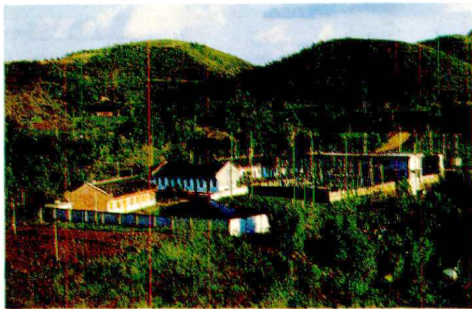
观桥变电站外景
