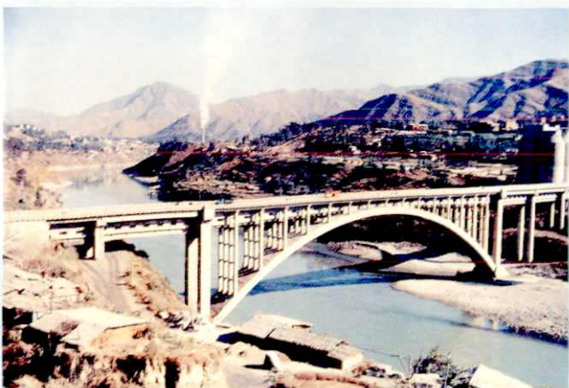
宝鼎大桥（中国唯一上层通车下层输煤两用桥）
