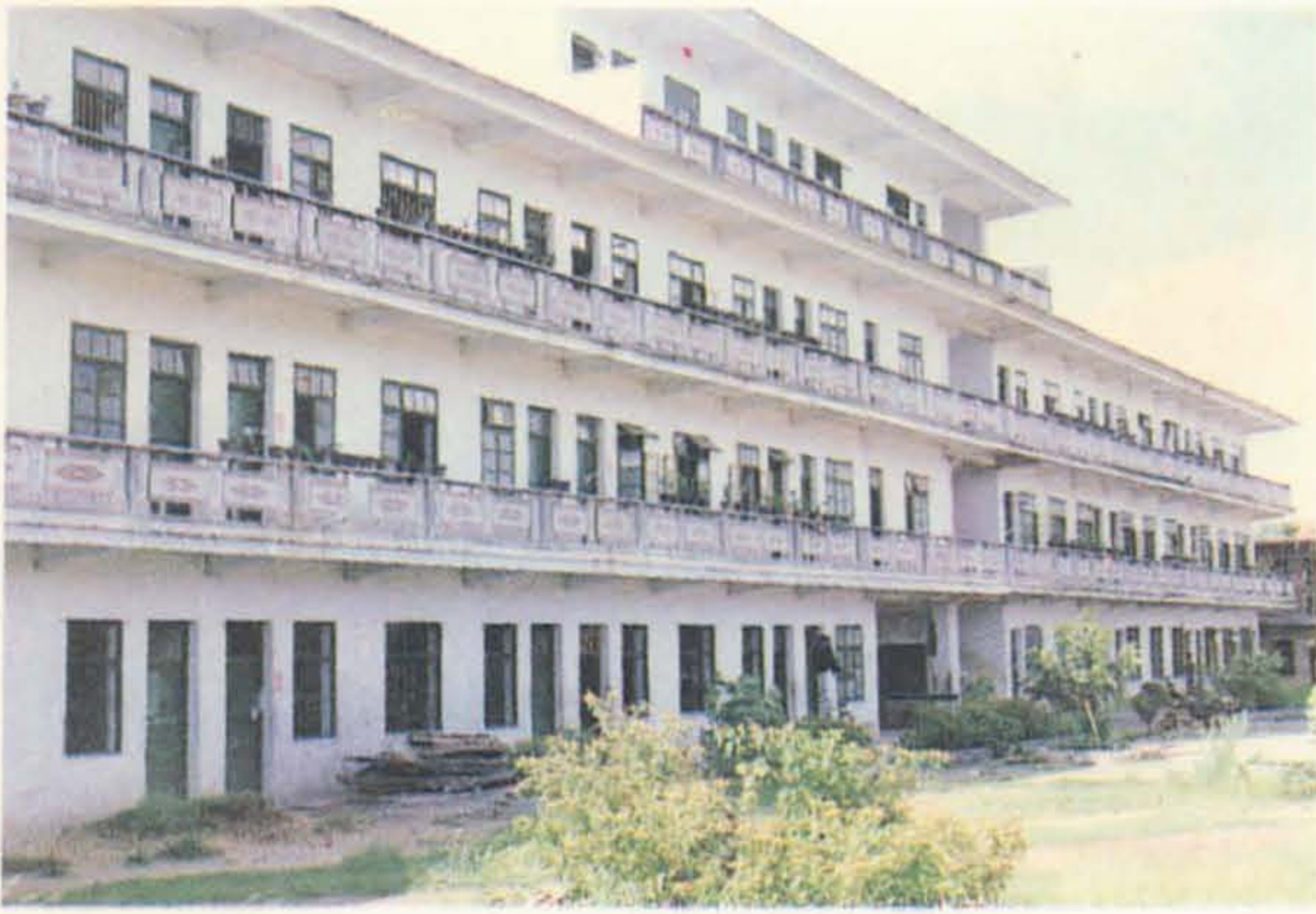
新桥初中教学大楼
