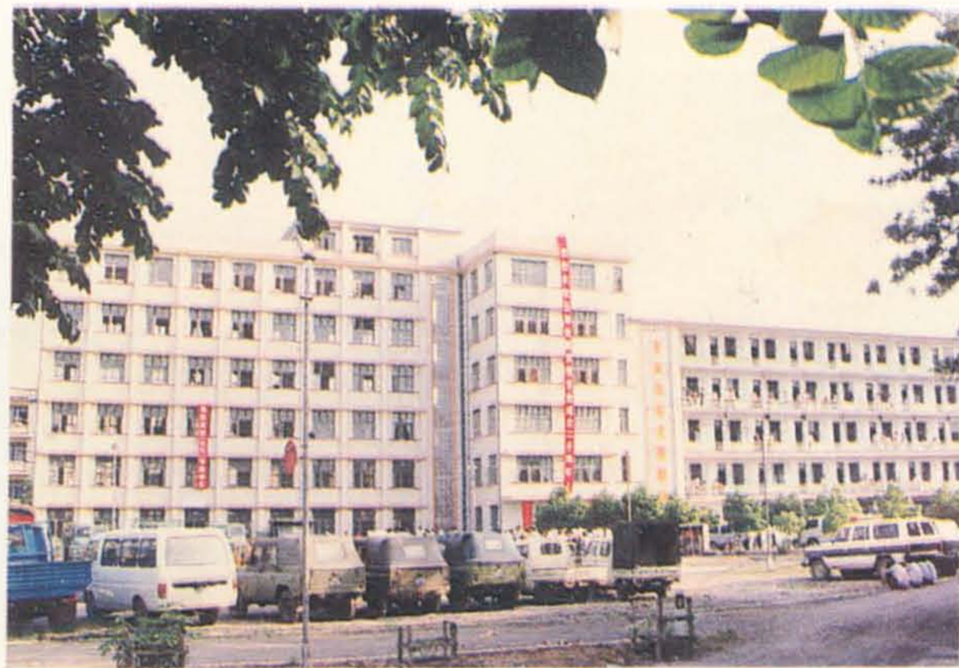
玉林地区农机学校教学大楼
