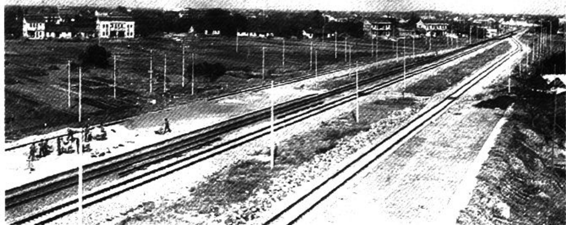
铁路复线铺筑
