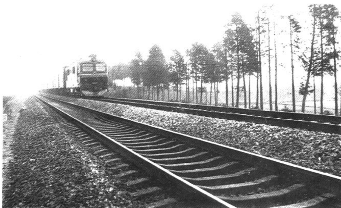
沪杭铁路海宁段复线
