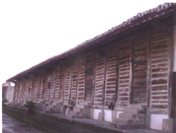
清朝道光年间修建的木板仓
