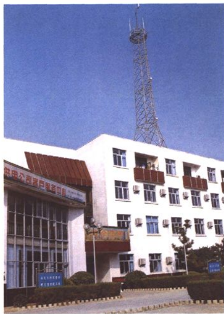
扬中市供电公司(2002年摄)
