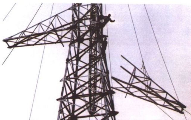
施工人员吊装铁塔 (1998 年 5 月摄)
