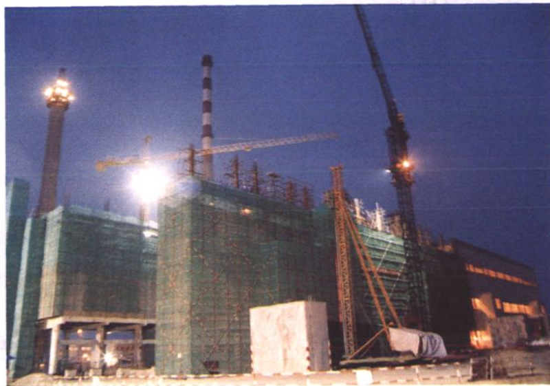
建设中的镇江电 厂二期主厂房(2002年 9月摄)
