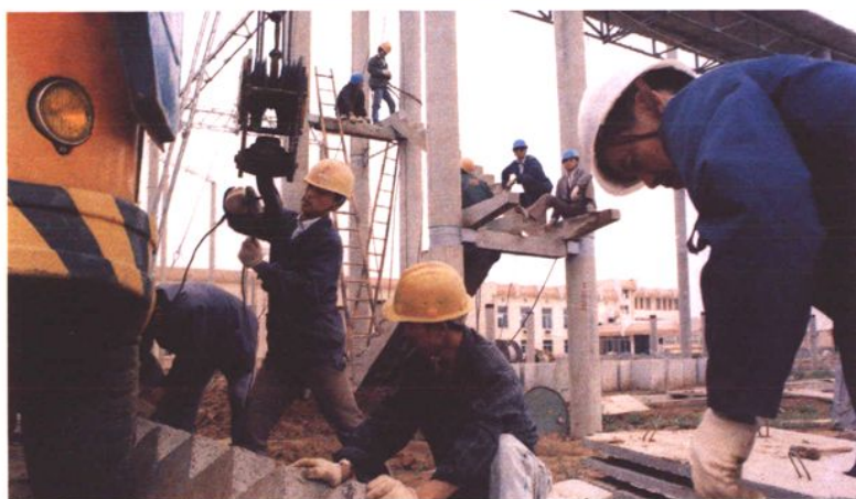
建设中的 220 千伏 丁卯变电所(1993 年摄)
