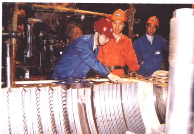
谏壁发电厂 30 万千瓦机组改造 (1998~2002 年)
