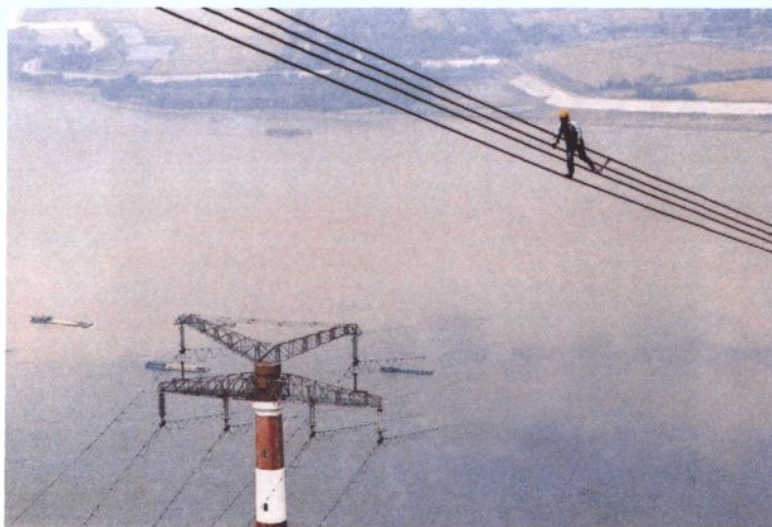
500 千伏长江大跨越踏线巡视(1996年4月摄)
