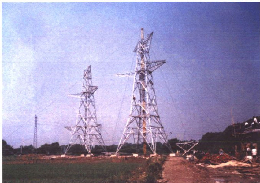
500 千伏线路施工(1988 年摄)
