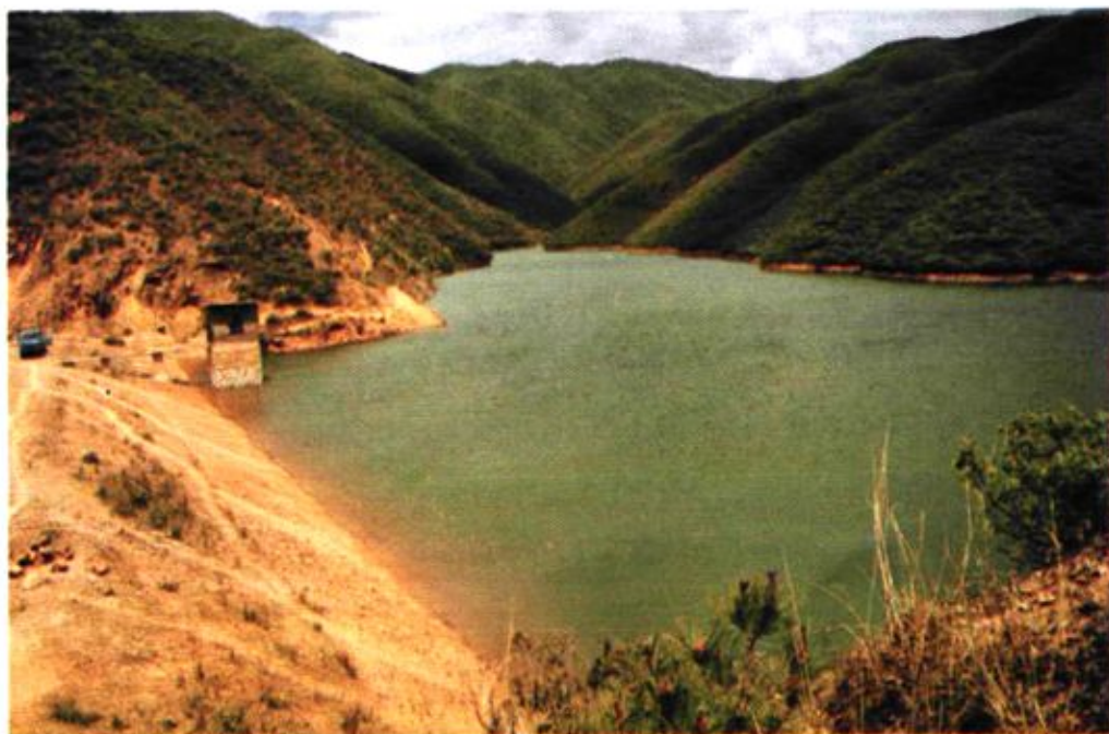
位于丛山中的瑶冲水库。
