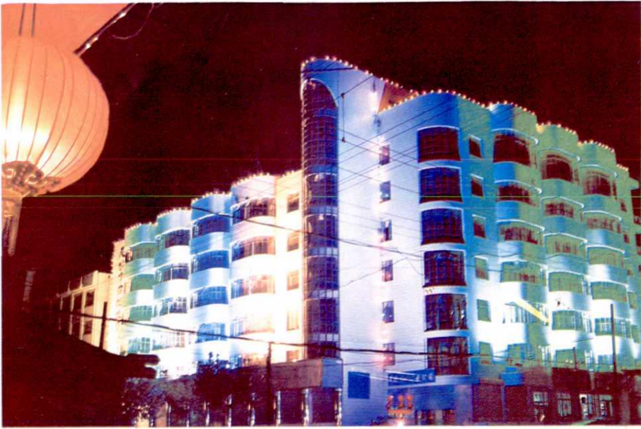
天水市财政局综合办公大楼
