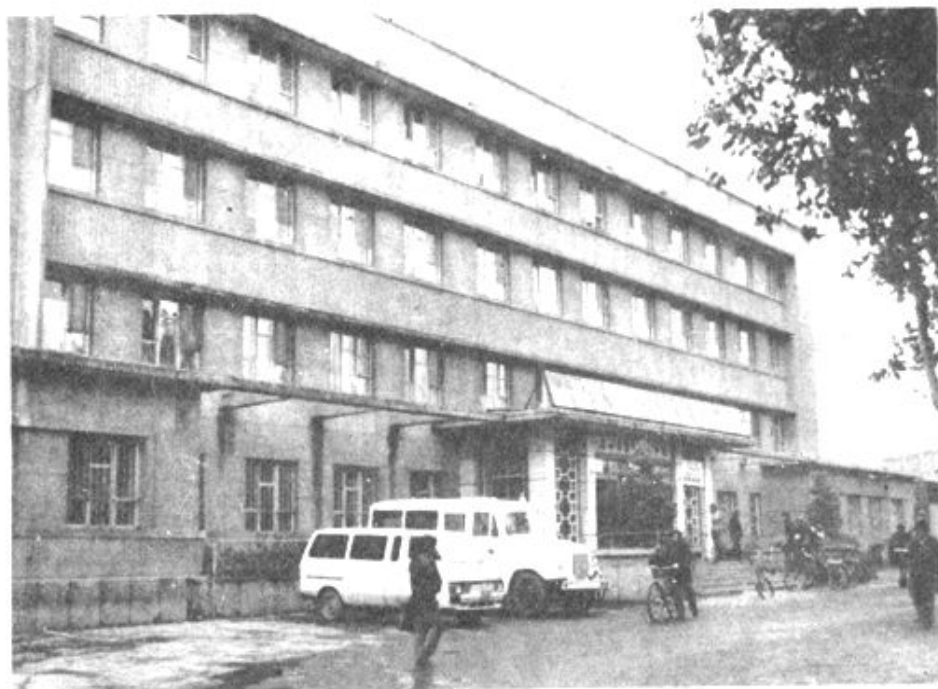
乌市中医院门诊大楼
