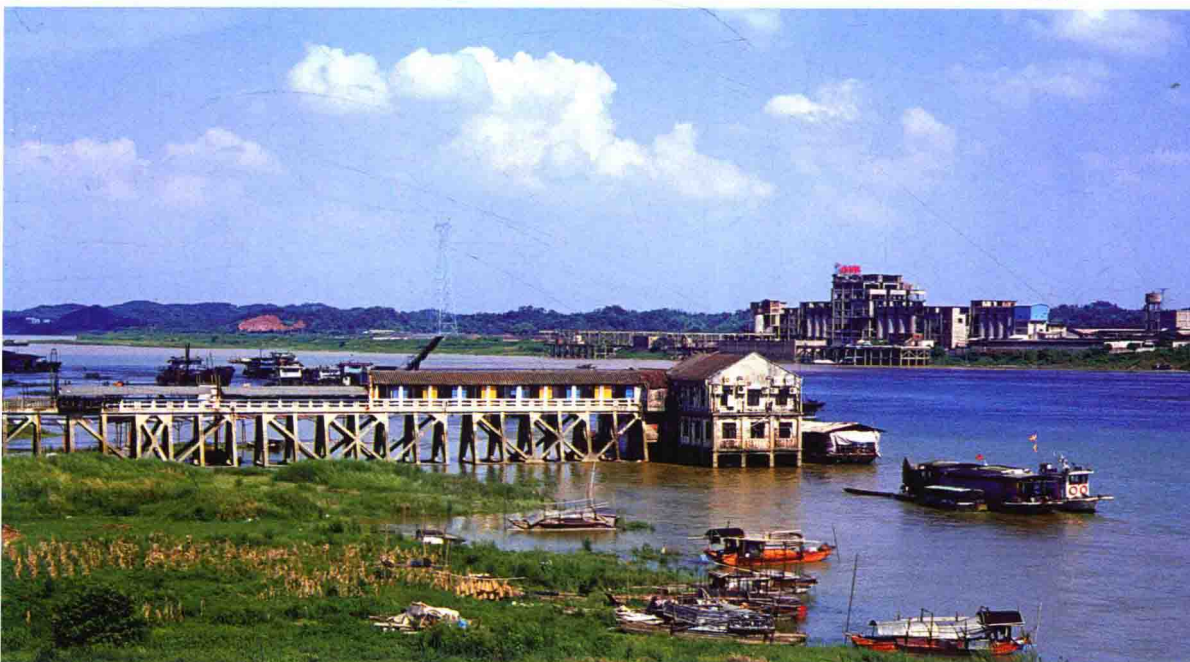
▲ 半江桥——三水旧县城河口北江边的桥形码头（建于1936年，桥长237.5米，宽3.8米，连接江心的3层码头）
