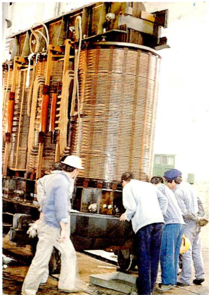
▷ 检修变压器(秦昌展摄)
