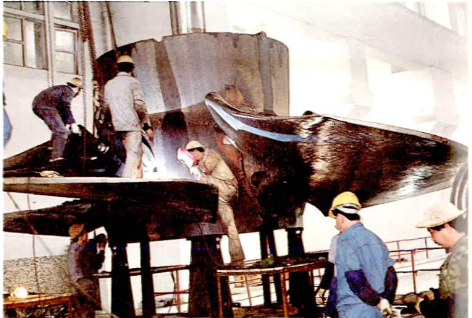
▽ 安装水轮机转轮(秦昌展摄)
