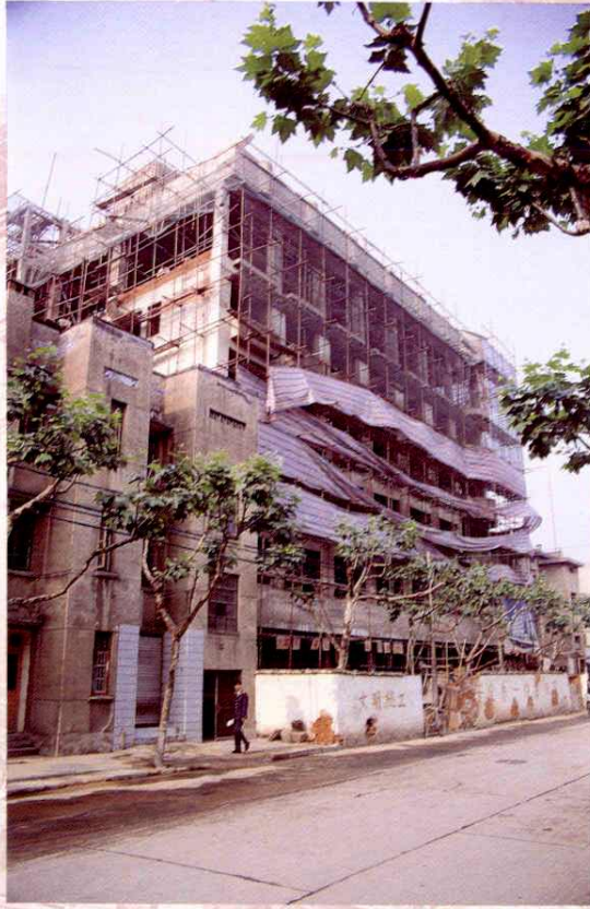
建设中的水利大厦
