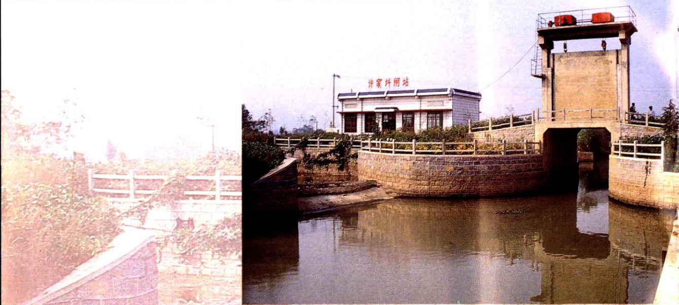
许家斗闸站外景
