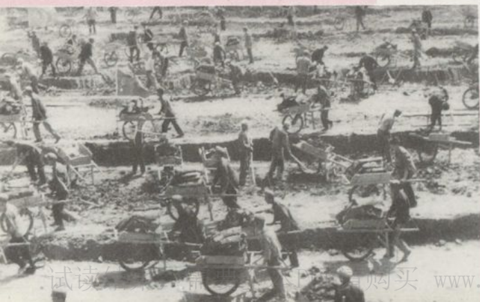
开挖大广安干渠
