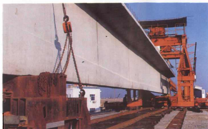
梅溪水库建造工地
