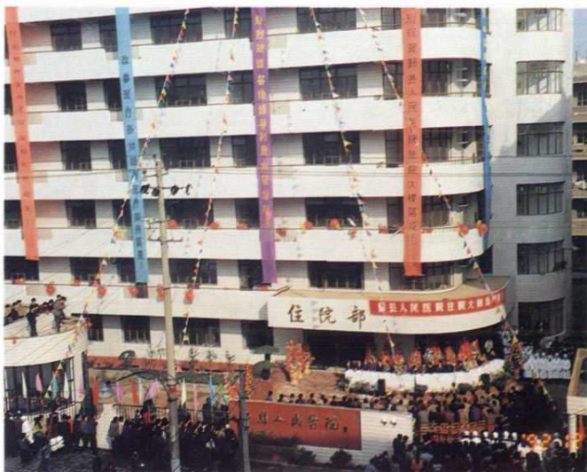
县人民医院住院楼
