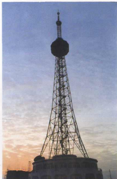
县电视台发射塔
