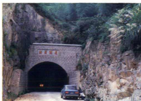
栢岭公路隧道
