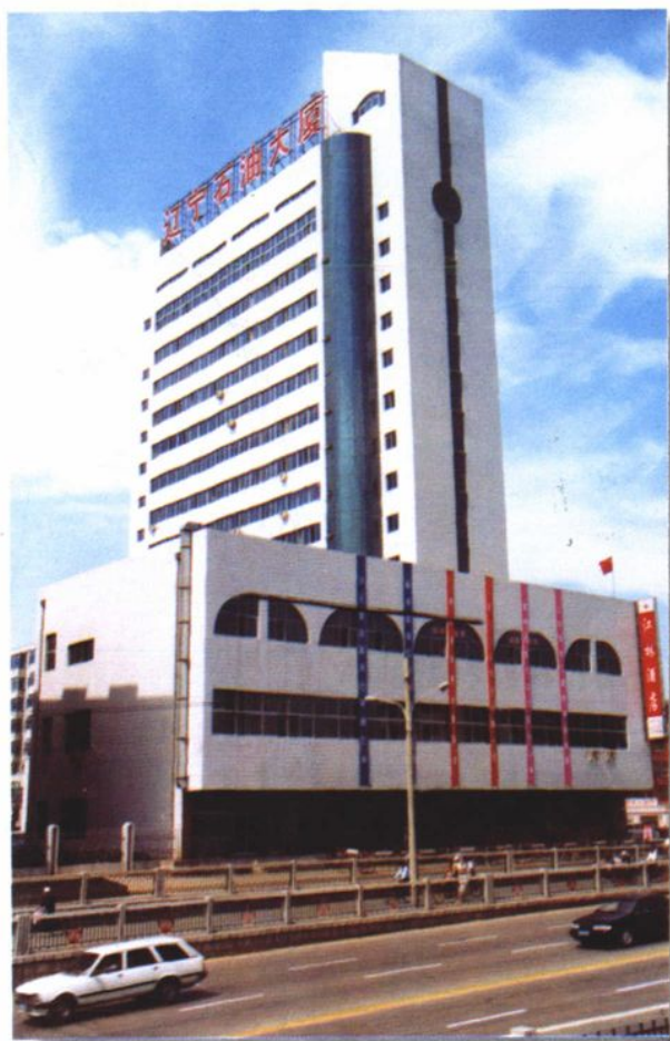
1997年6月投入使用的 辽宁省石油总公司办公大楼
