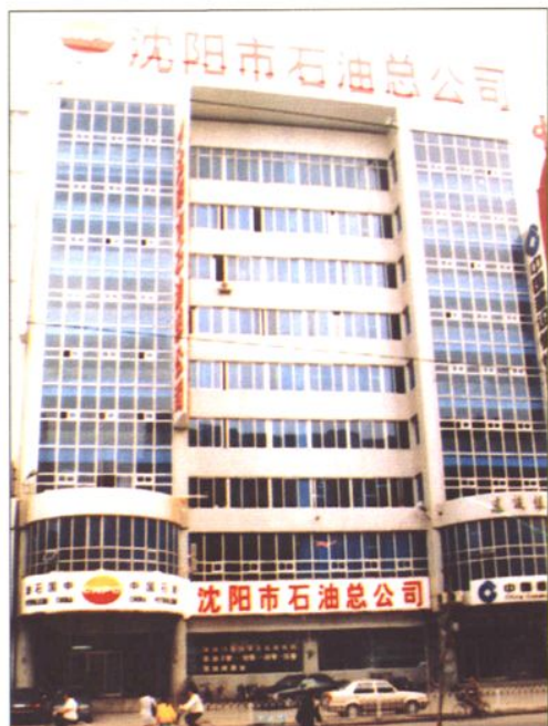
沈阳市石油公司办公大楼
