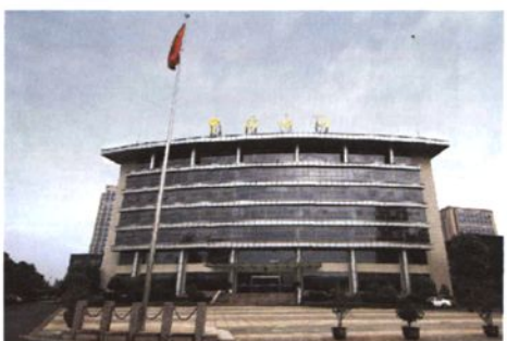
上虞办事处大楼
