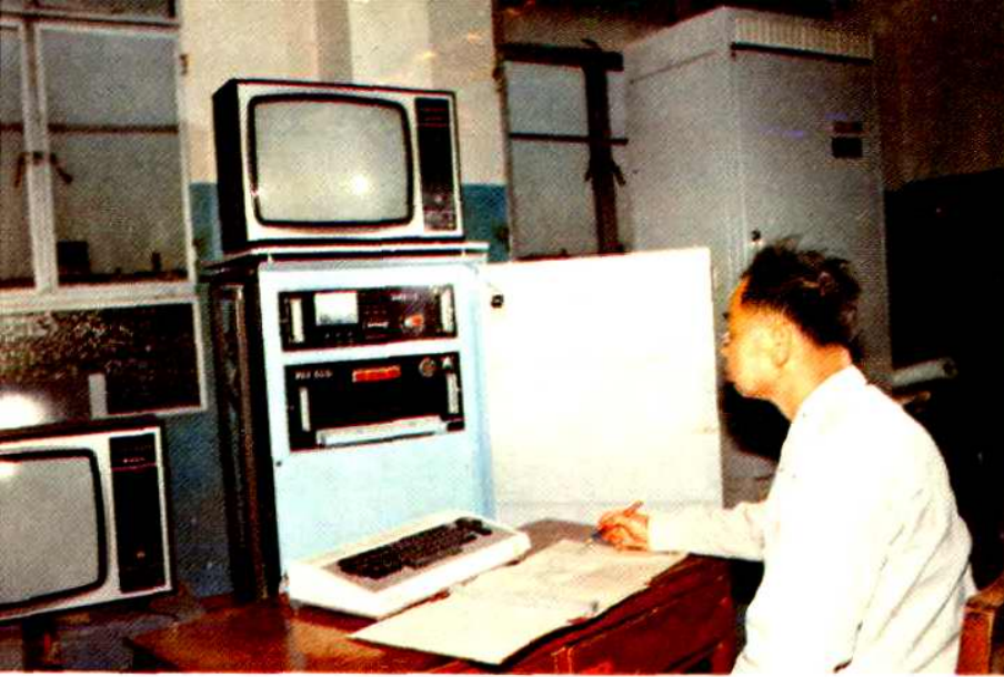
电力调度远动装置
