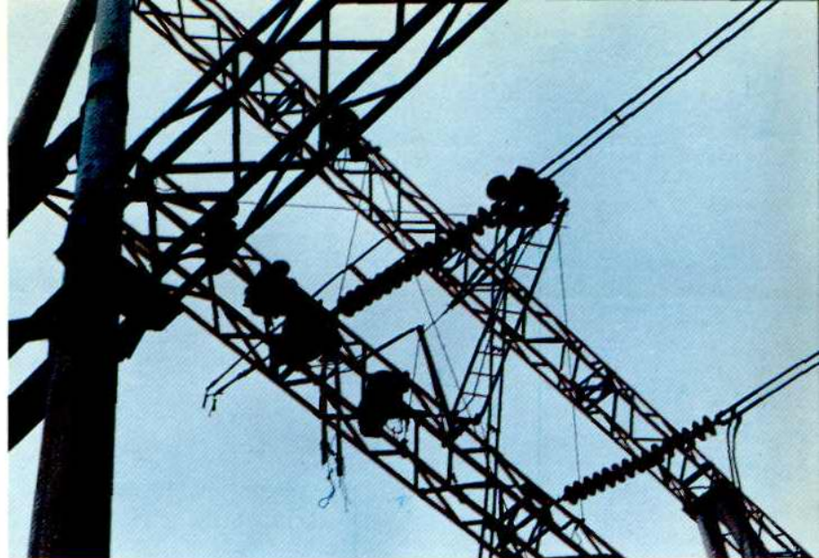
带电更换220 千伏绝缘子串
