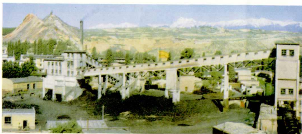
乌鲁木齐矿务局苇湖梁煤矿
