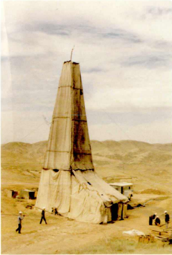
新疆煤田地质勘探公司野外钻探工地
