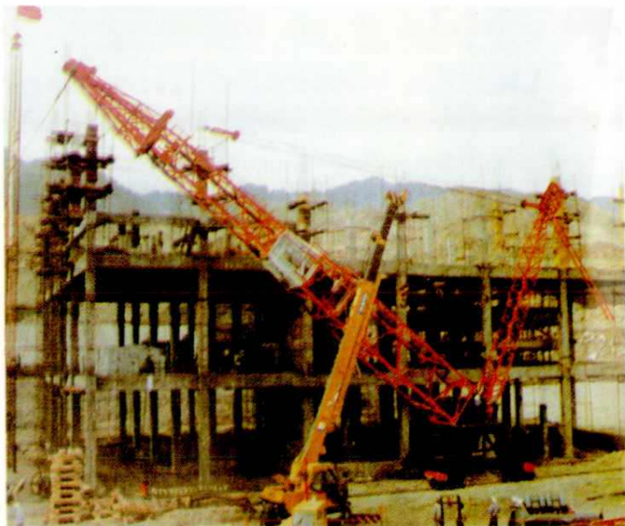
新疆煤矿建设工程处承建的艾维尔沟煤矿洗煤工程施工现场
