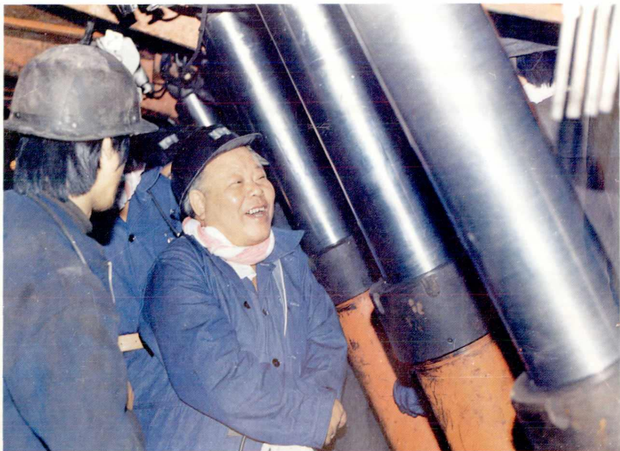
1987年8月煤炭工业部部长于洪恩在六道湾煤矿综采工作面视察
