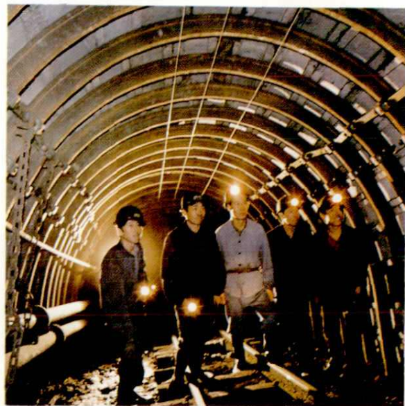
哈密矿务局一矿加固后的主斜井井筒
