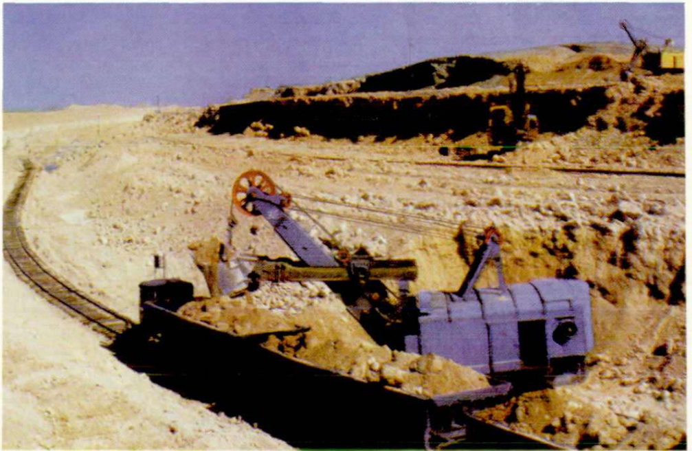
哈密矿务局露天矿西扩工程施工现场一角
