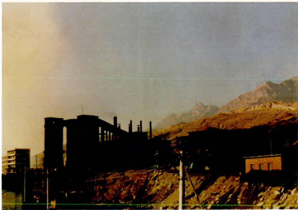
艾维尔沟煤矿洗煤厂
