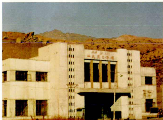
艾维尔沟煤矿一九三〇平硐
