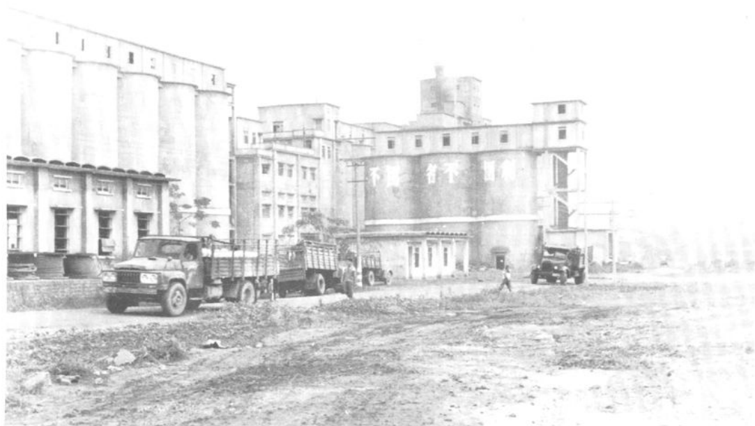
70 年代兴建的年产 8 万吨水泥的八一水泥厂。
