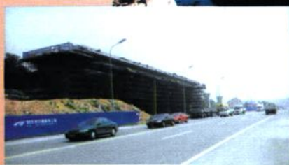
施工中的 大连202轻轨 延伸工程
