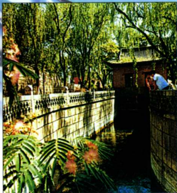
工农业分水闸
