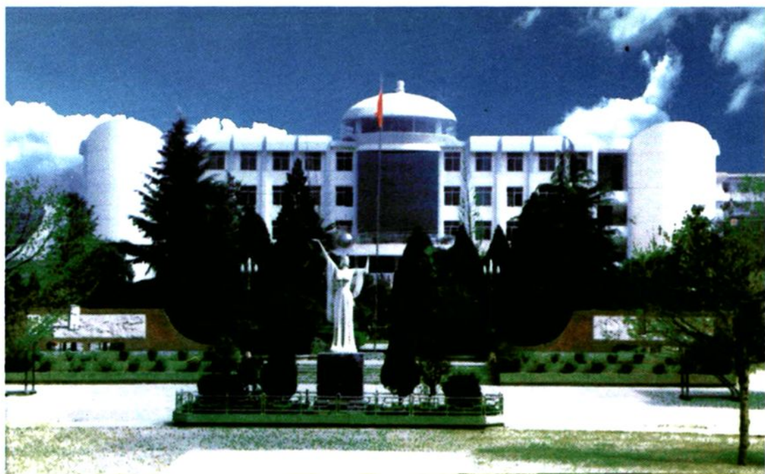
综合实验办公楼
